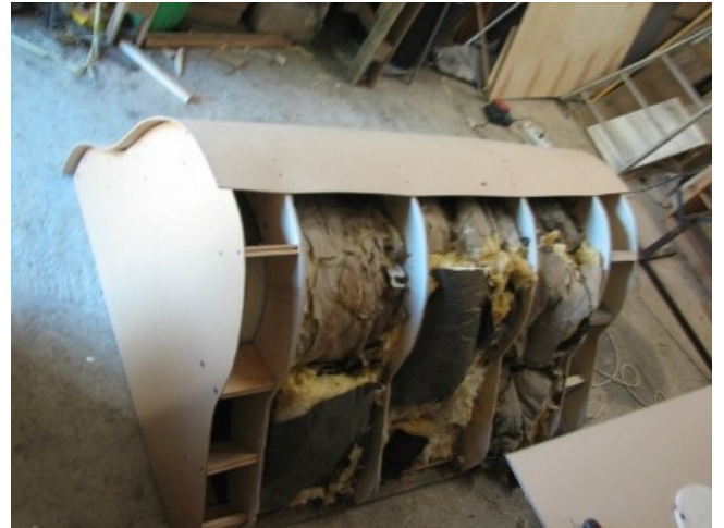
Habillage arrière, les profilés bois fond 15 cm de large, il y aura donc cette épaisseur d'isolant tout autour du CESS.
